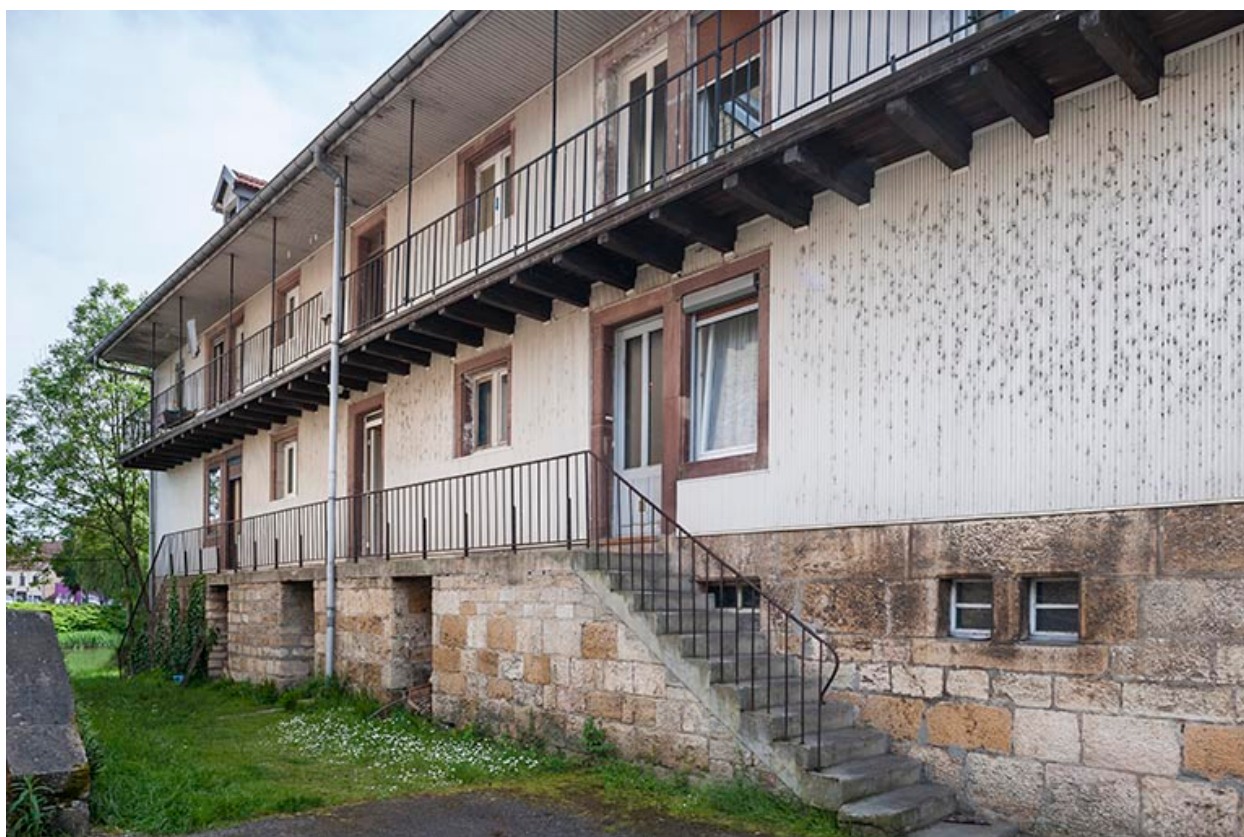
Logement oriental. Détail de la façade nord.
