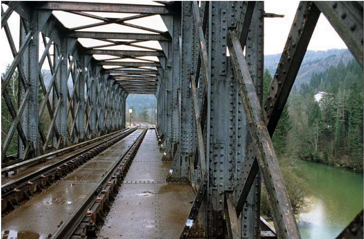
Charpente métallique, tablier et voie.
