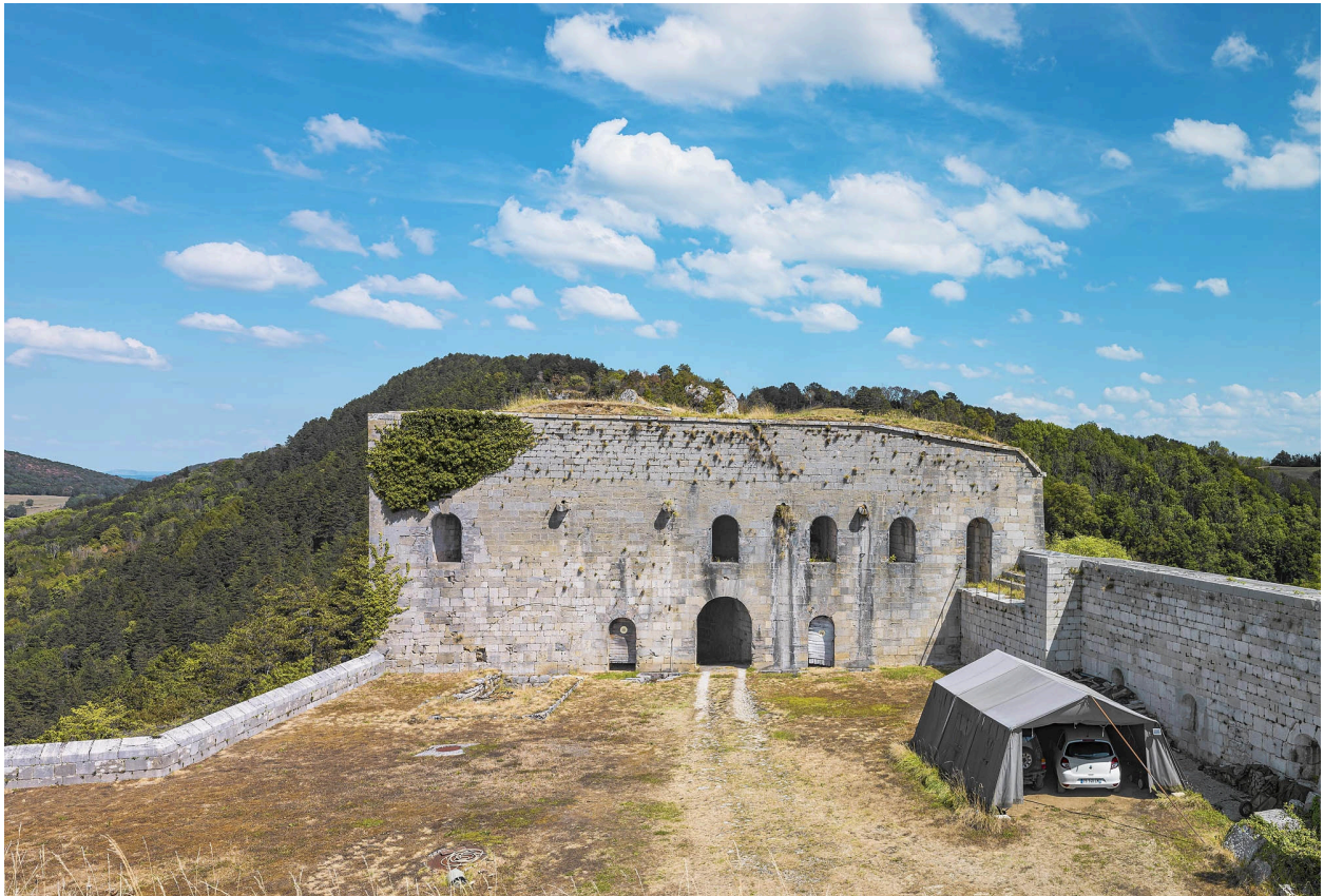
La façade postérieure.
