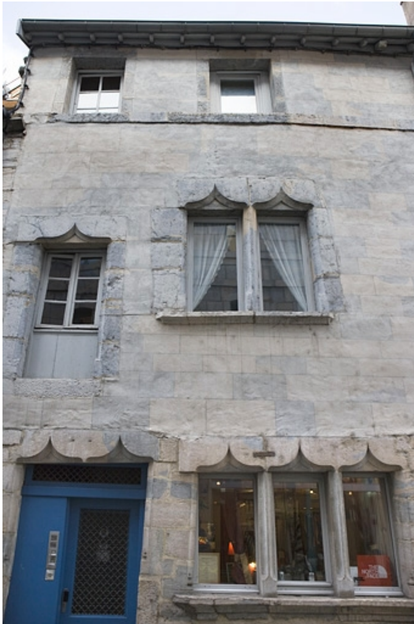
Vue d'ensemble de la façade sur la rue Renan, de face.
