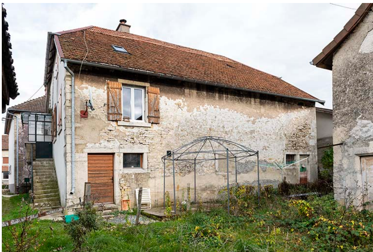
Grange : façade postérieure.
