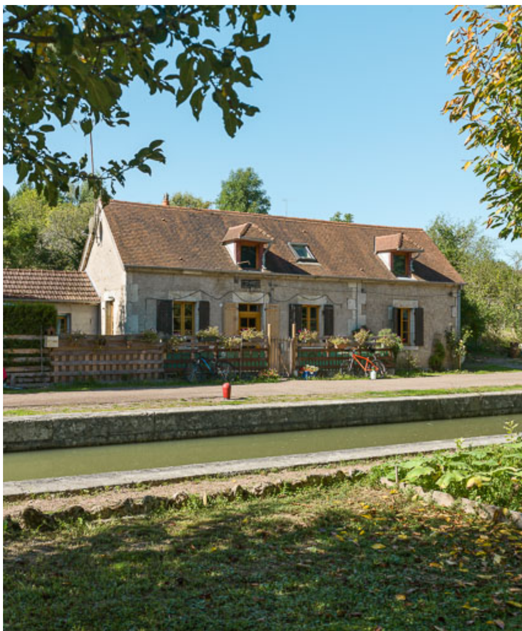
Vue de la maison éclusière.
