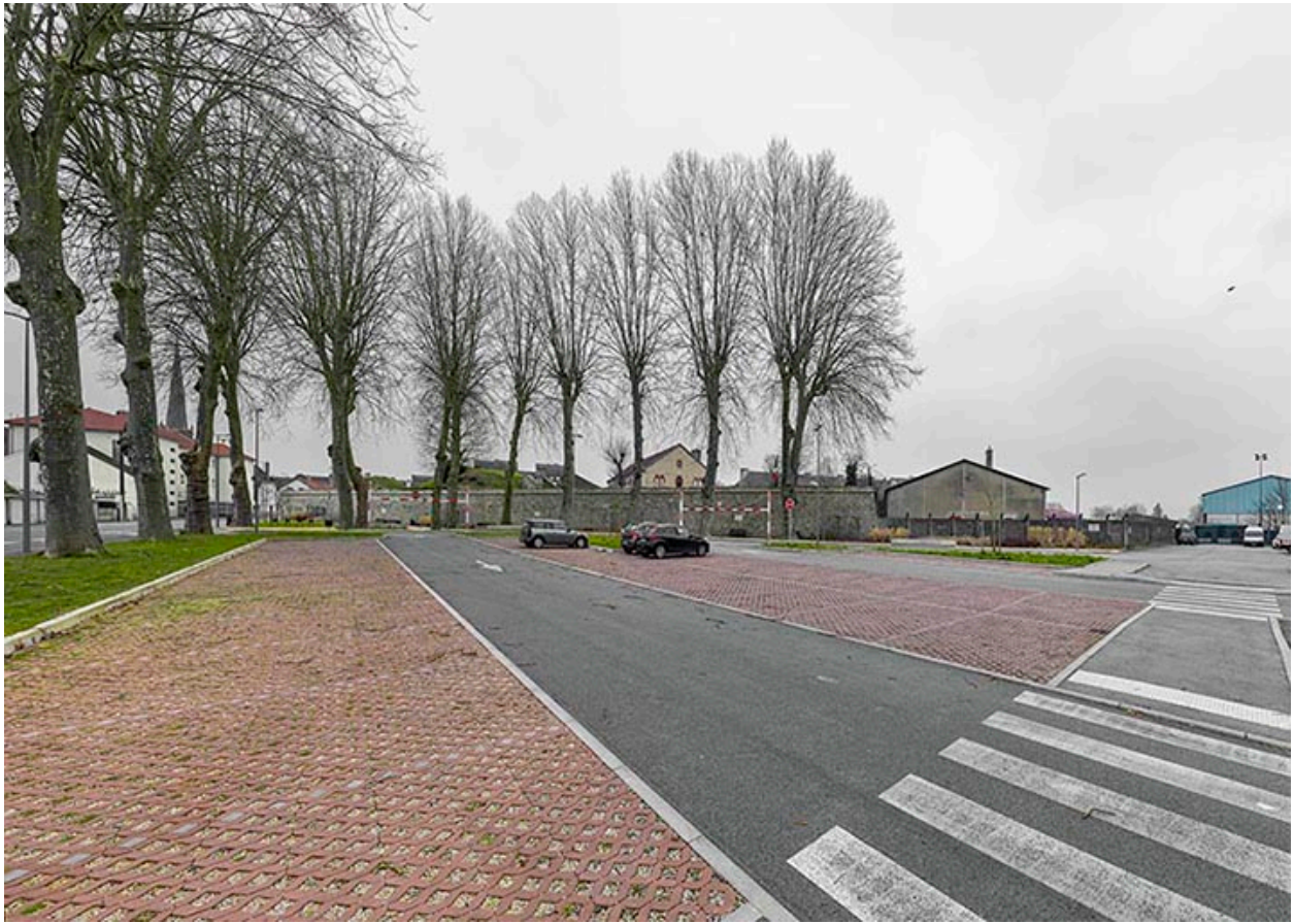
Vue d'ensemble du bastion depuis le parking Bonaparte.
