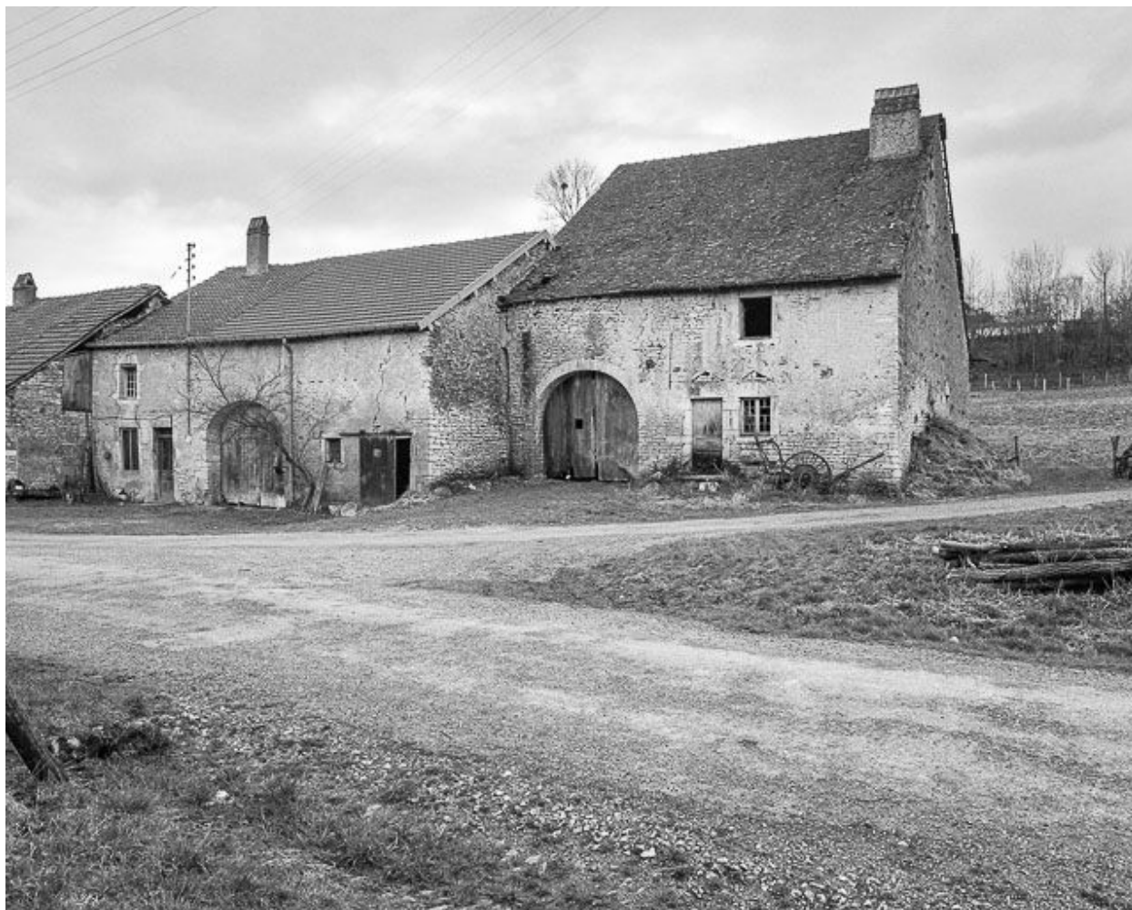
Ferme située rue Capet à Gézier.
