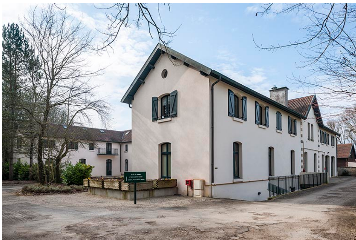
Vue d'ensemble du bâtiment des communs.
