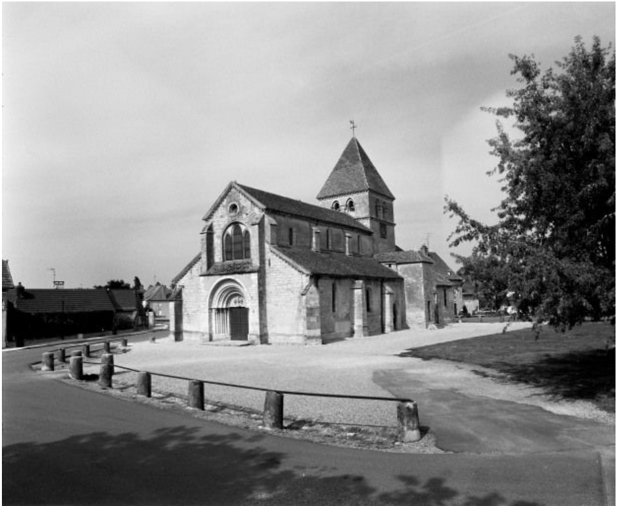
Vue d'ensemble : façade et élévation droite.
