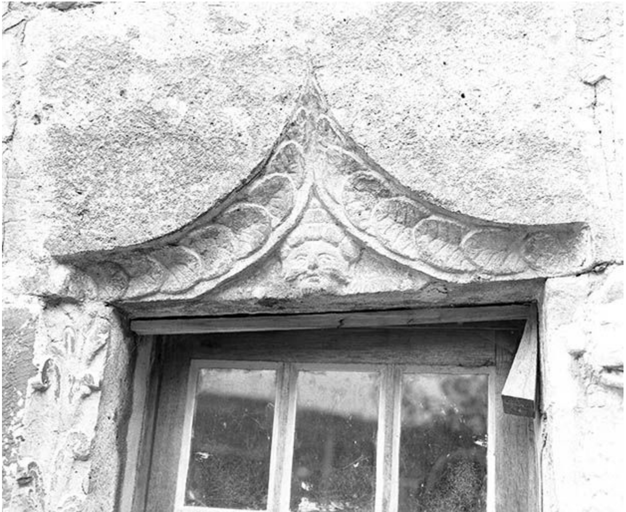
Détail du linteau de la baie gauche au rez-de-chaussée, côté cour.
