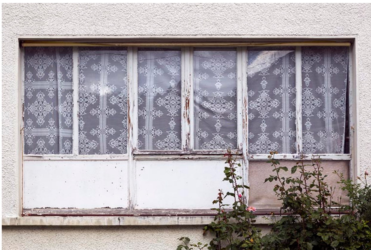
Façade antérieure : fenêtre d'atelier au rez-de-chaussée.
