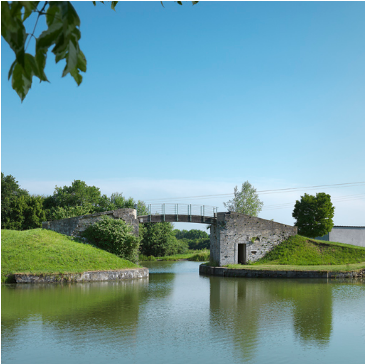
Vue de la passerelle haute, de face.
