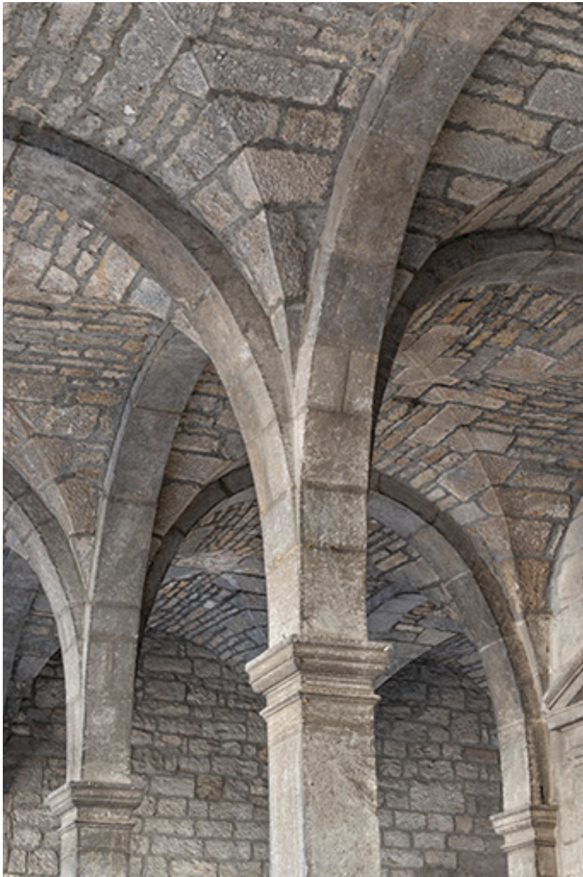
Détail des voûtes d'arêtes.
