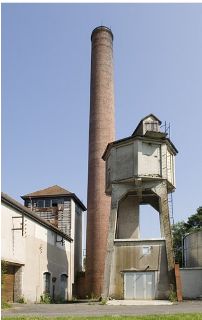
Cheminée et château d'eau.
