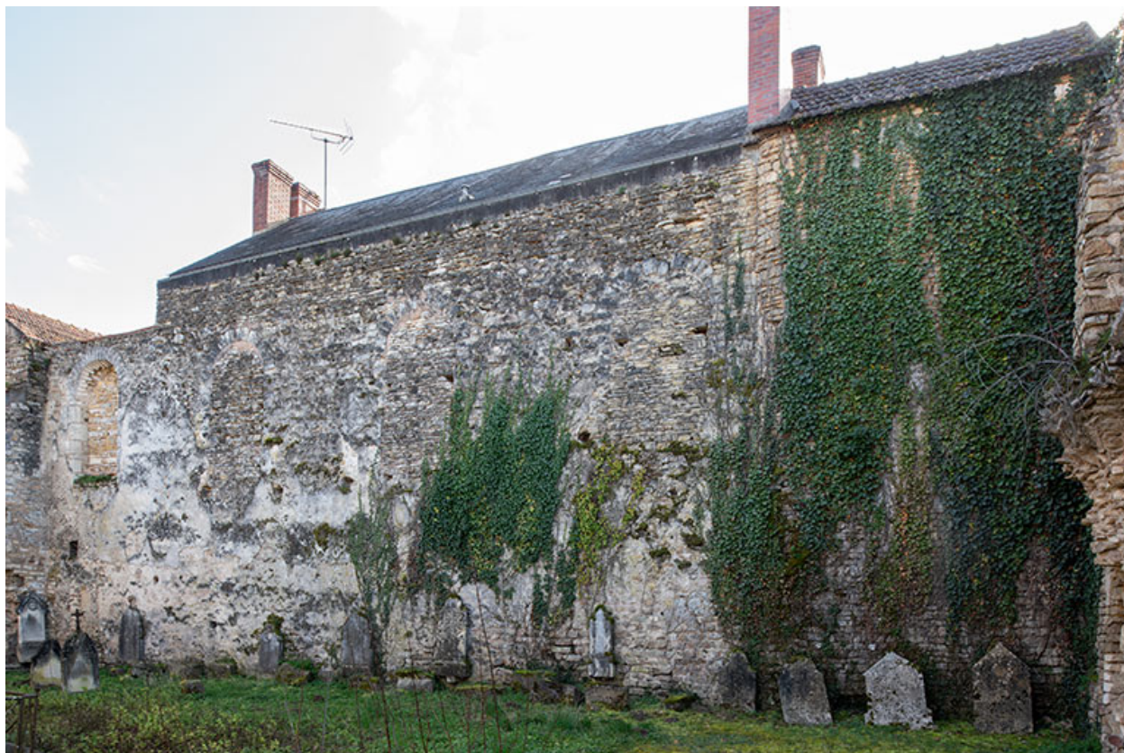
Le mur sud de l'église, côté intérieur.
