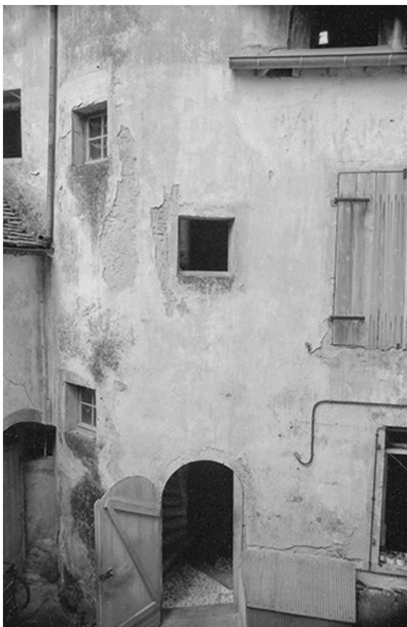
Bas de la tourelle d'escalier.
