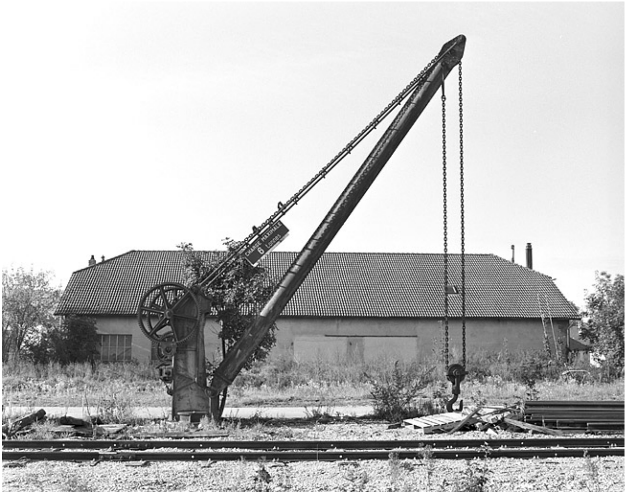
Vue d'ensemble de profil, depuis le nord-est.
