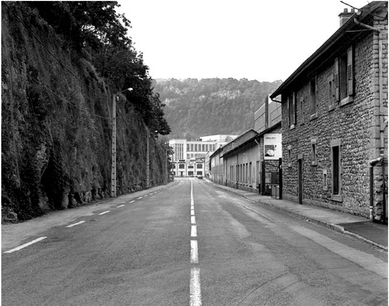
Avenue de Chardonnet : mur de l'usine B et perspective sur l'usine A.
