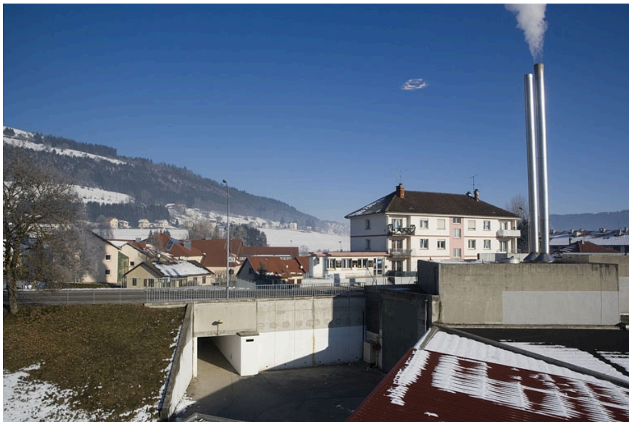
Site ancien : tunnel et chaufferie, depuis l'internat.
