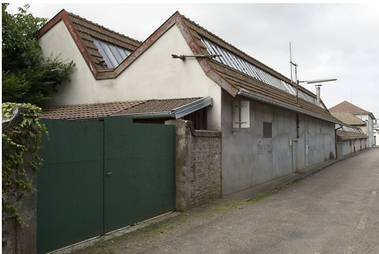
Façade nord de l'atelier de fabrication.
