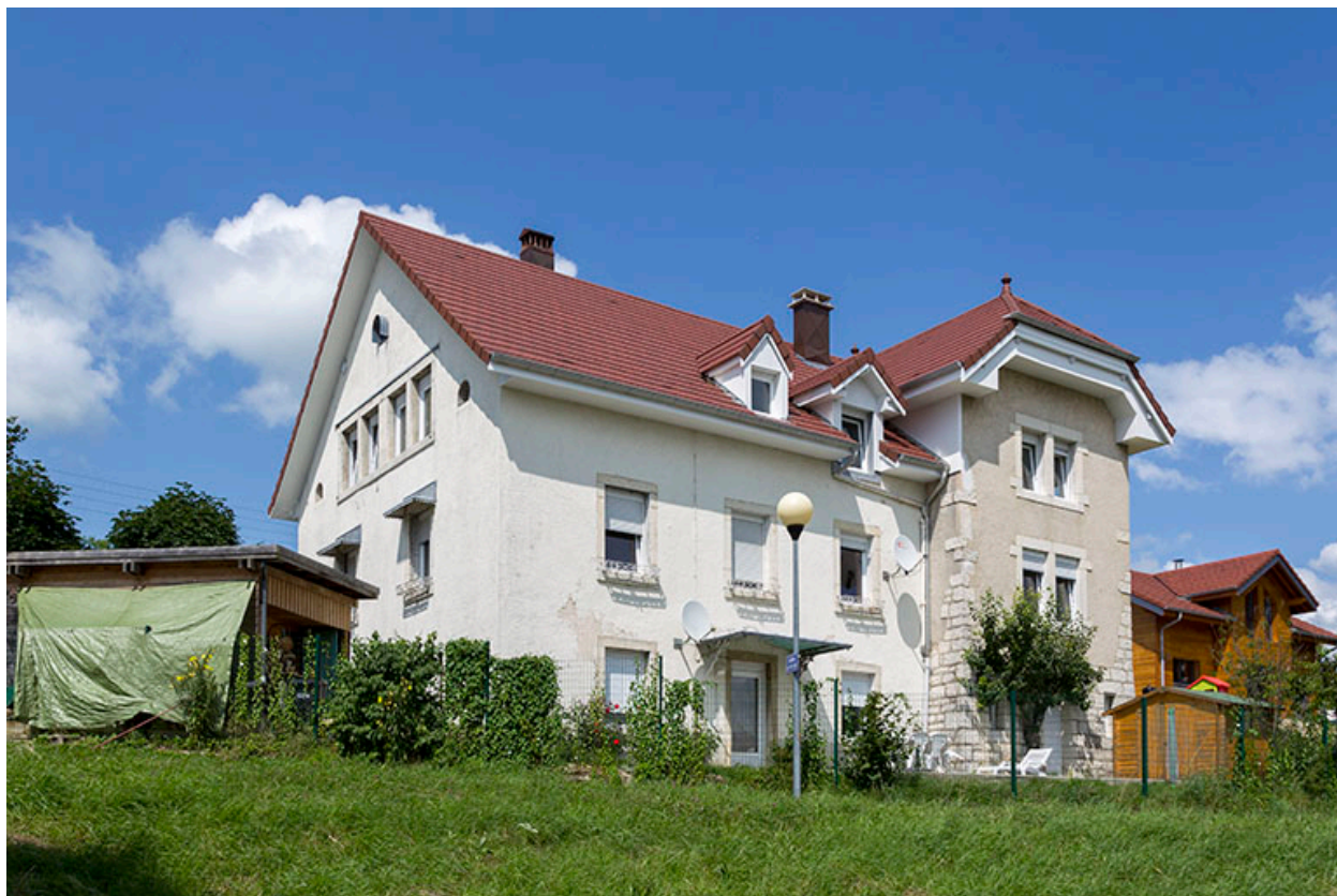
Façades postérieure et latérale droite.
