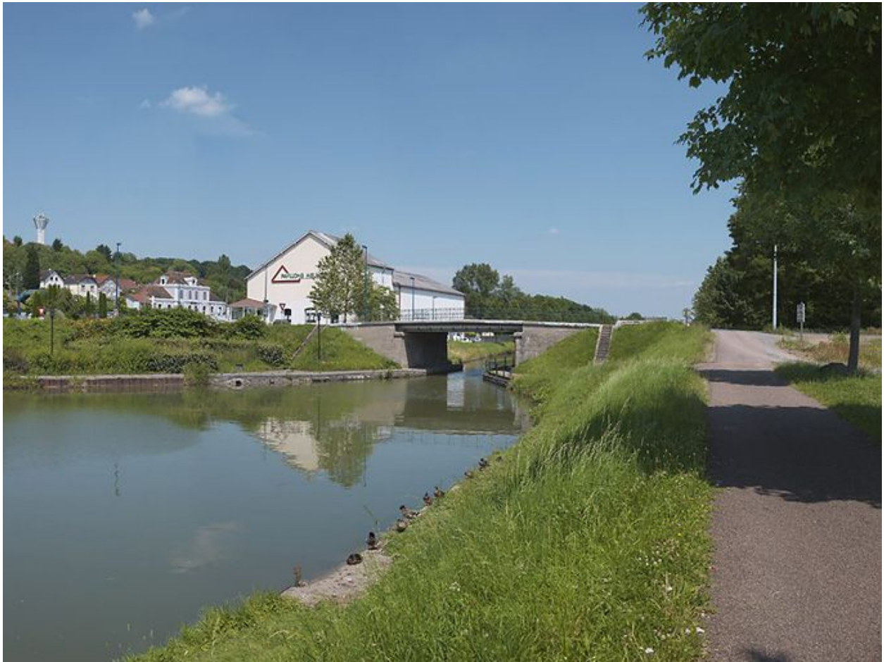
Vue d'ensemble d'aval.
