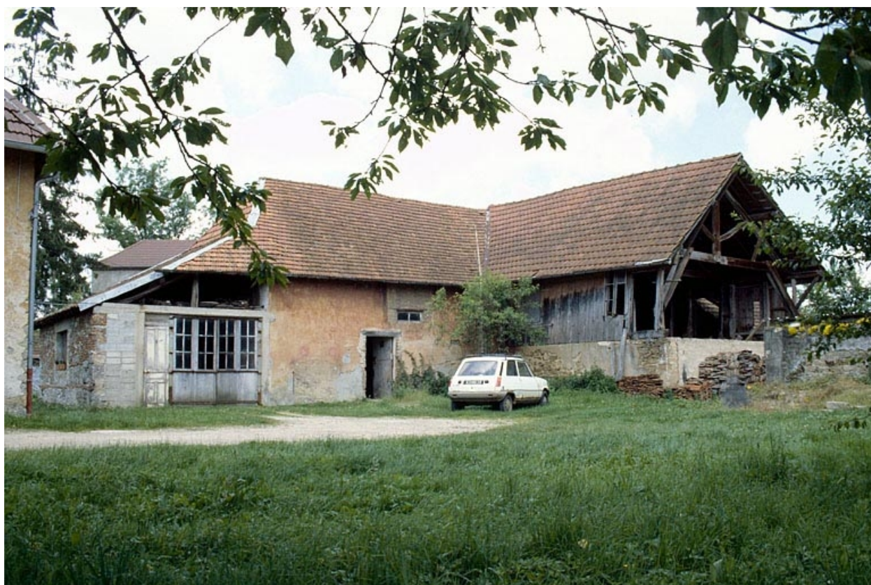
Atelier de fabrication (B), depuis le sud-est.
