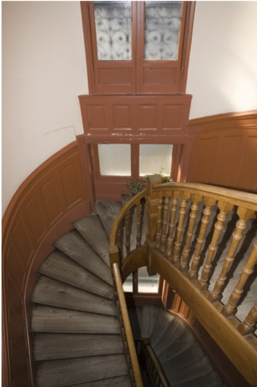
Détail d'une partie de l'escalier.
