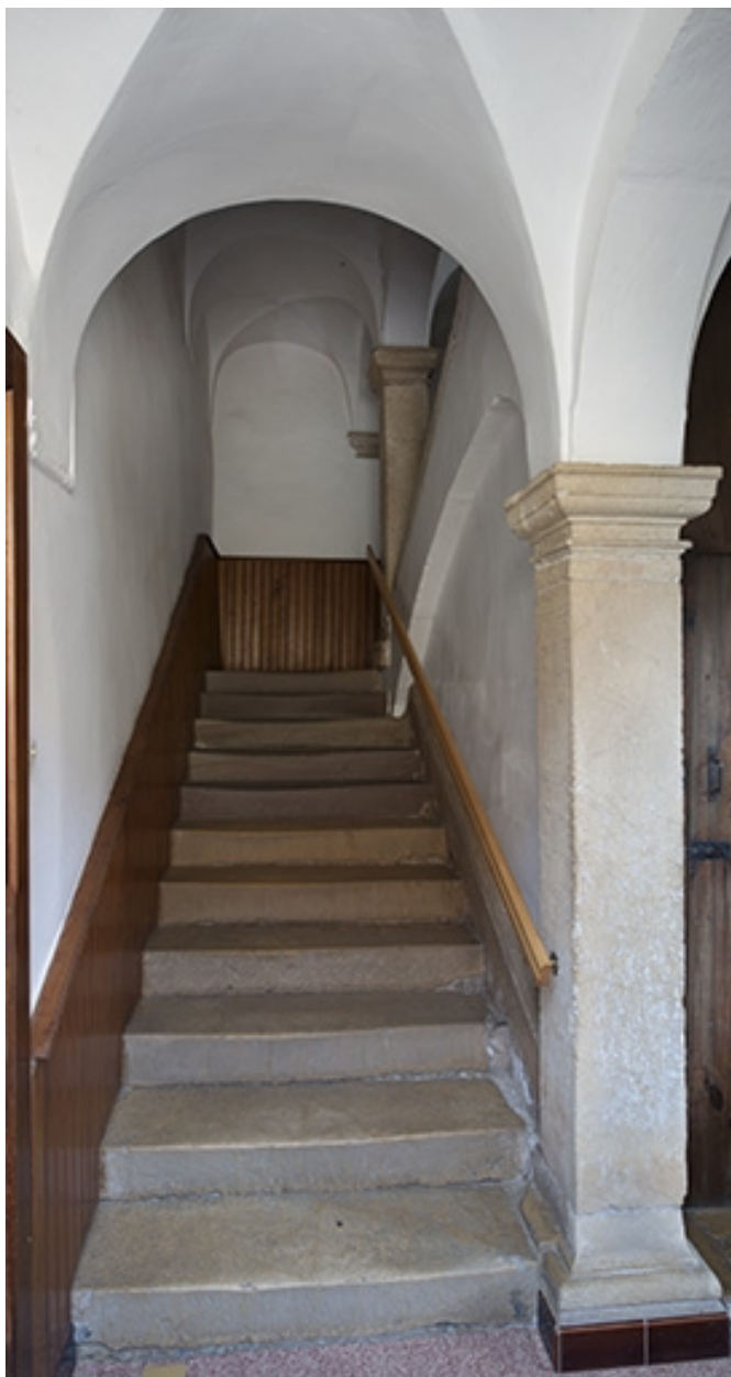
Départ de l'escalier intérieur conduisant à l'étage.
