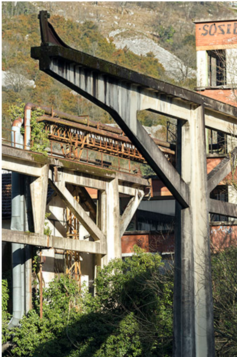
Etat en 2016. Usine A : détail du portique en béton du pont roulant.
