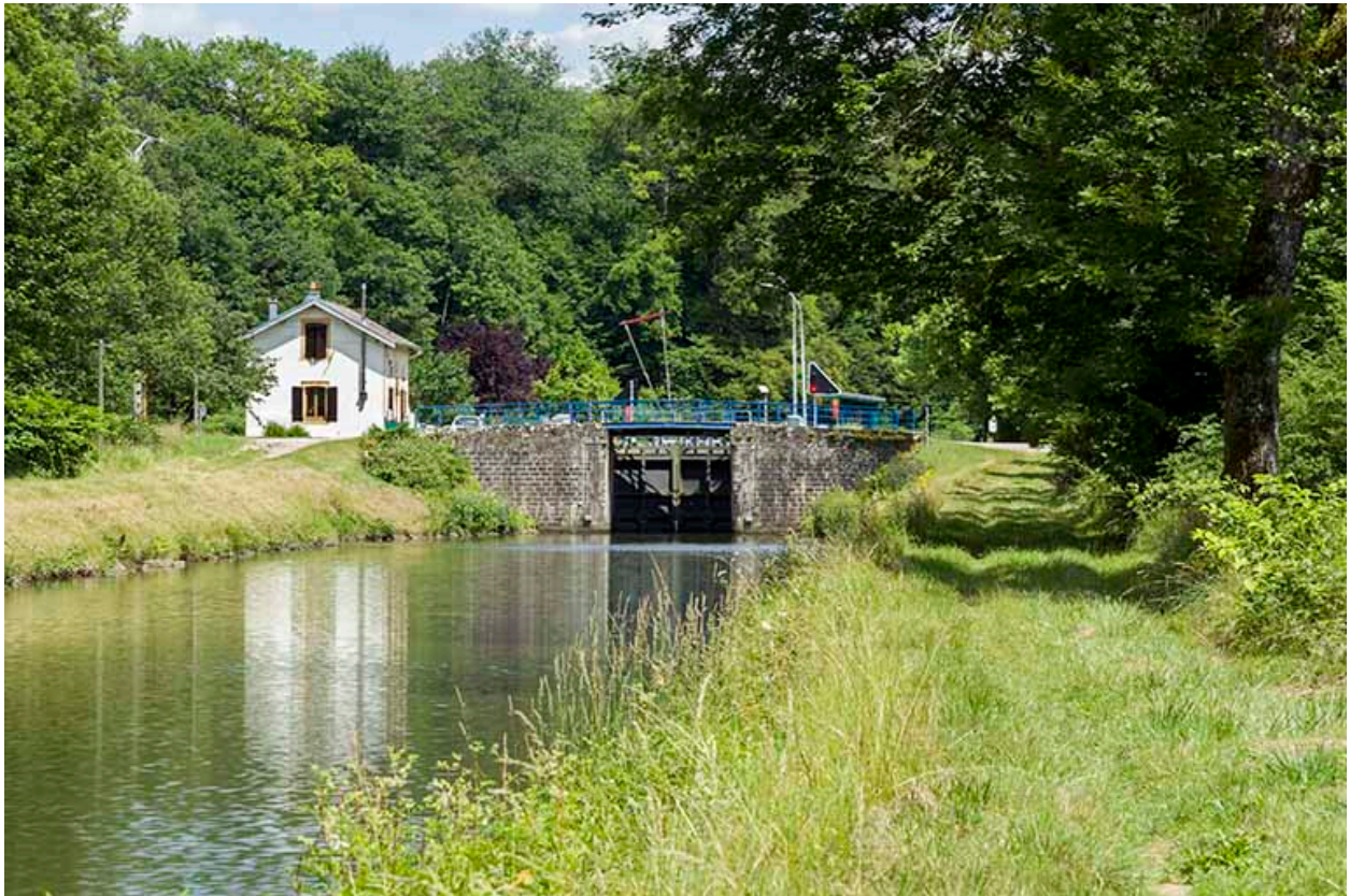
Vue d'ensemble depuis l'aval.
