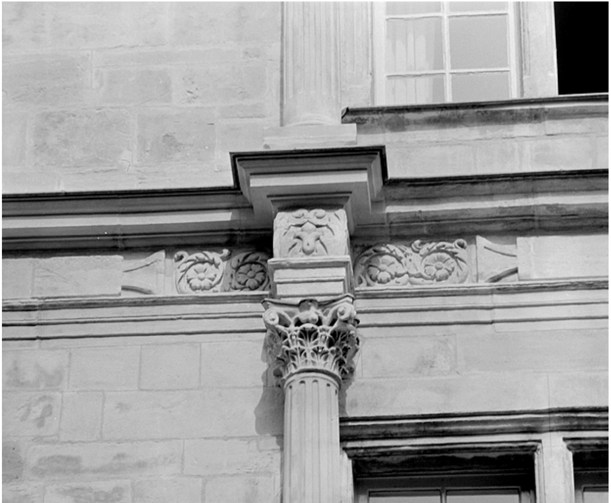
Façade sur la place, deuxième étage, chapiteau de l'ordre corinthien à droite de la travée centrale.
