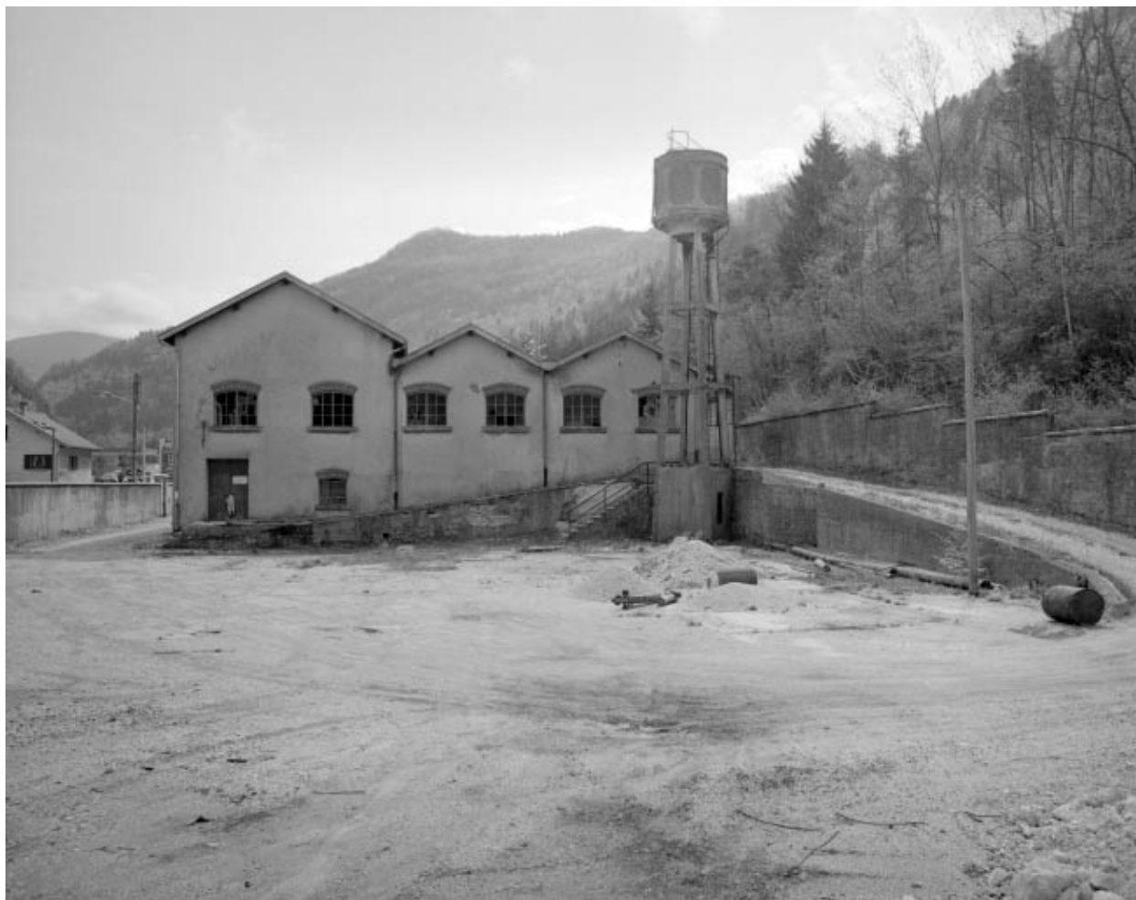
Cour, atelier de fabrication et château d'eau.
