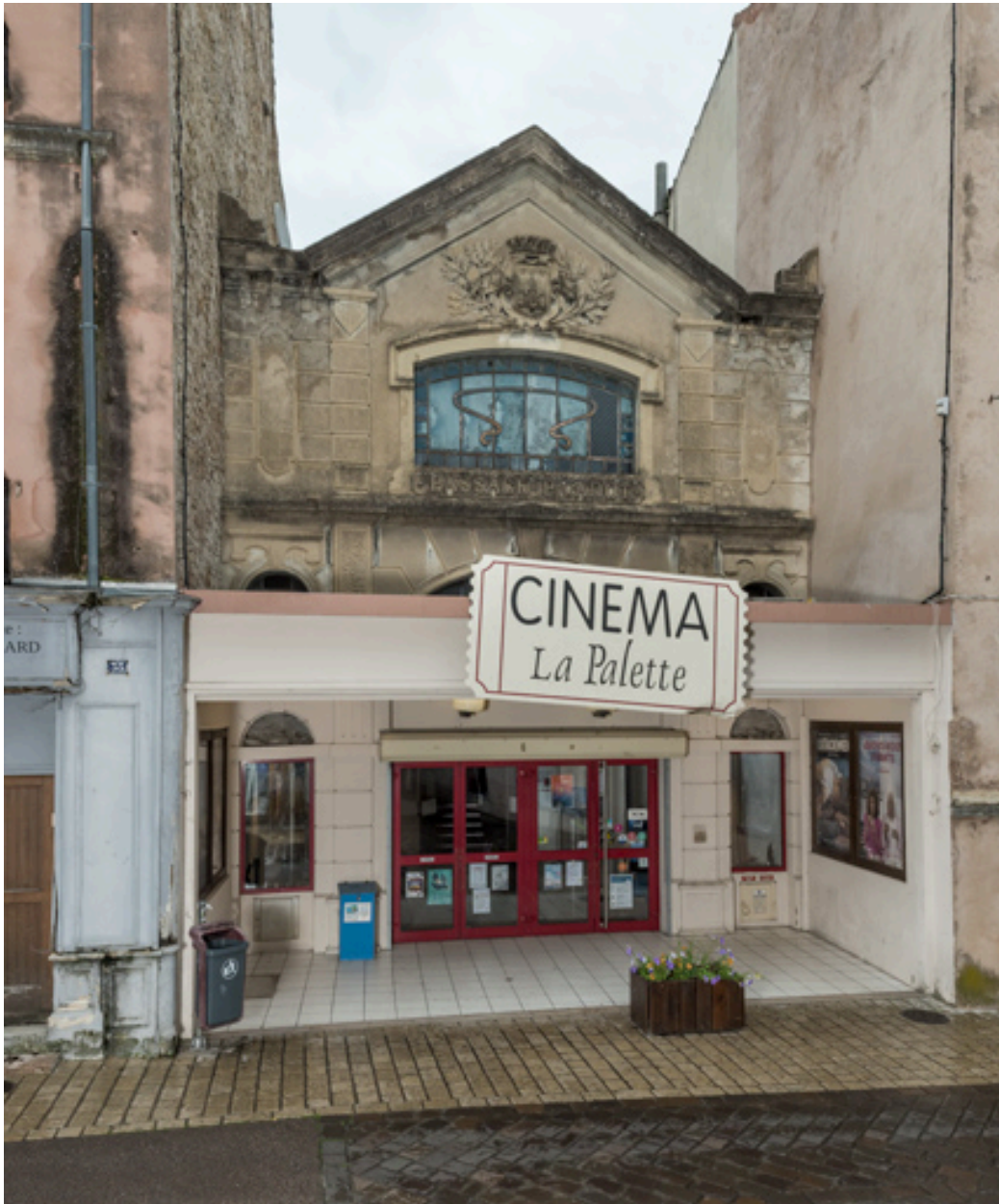
Façade antérieure, rue de la République.
