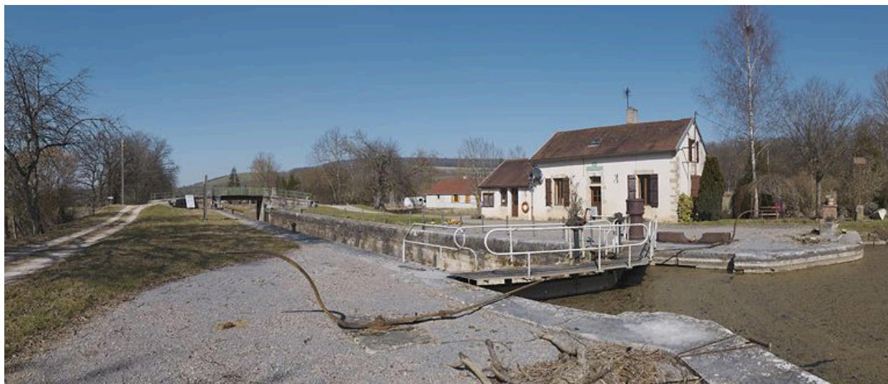
Le site d'écluse vu d'amont.
