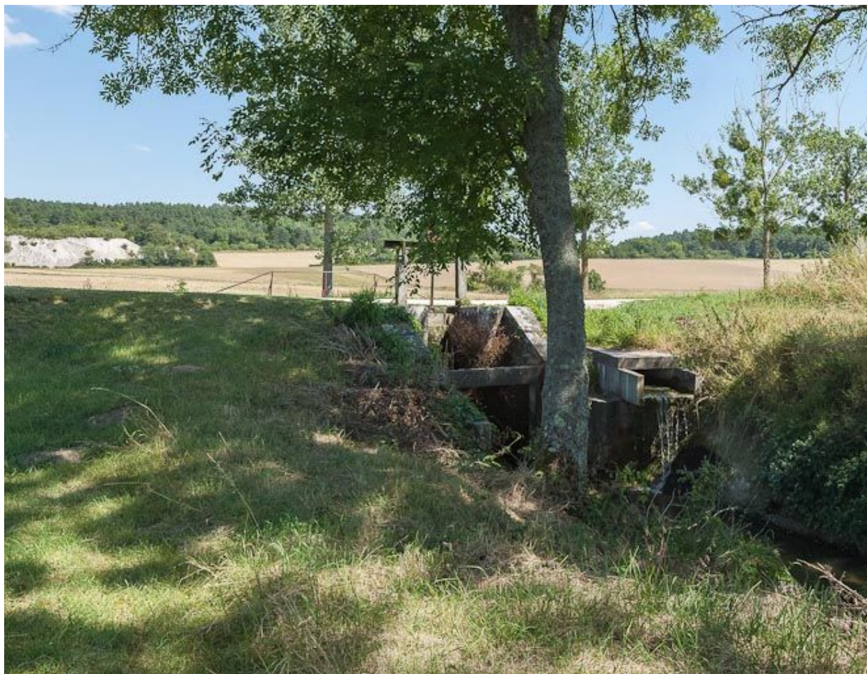
Déversoir avec vanne rive gauche.
