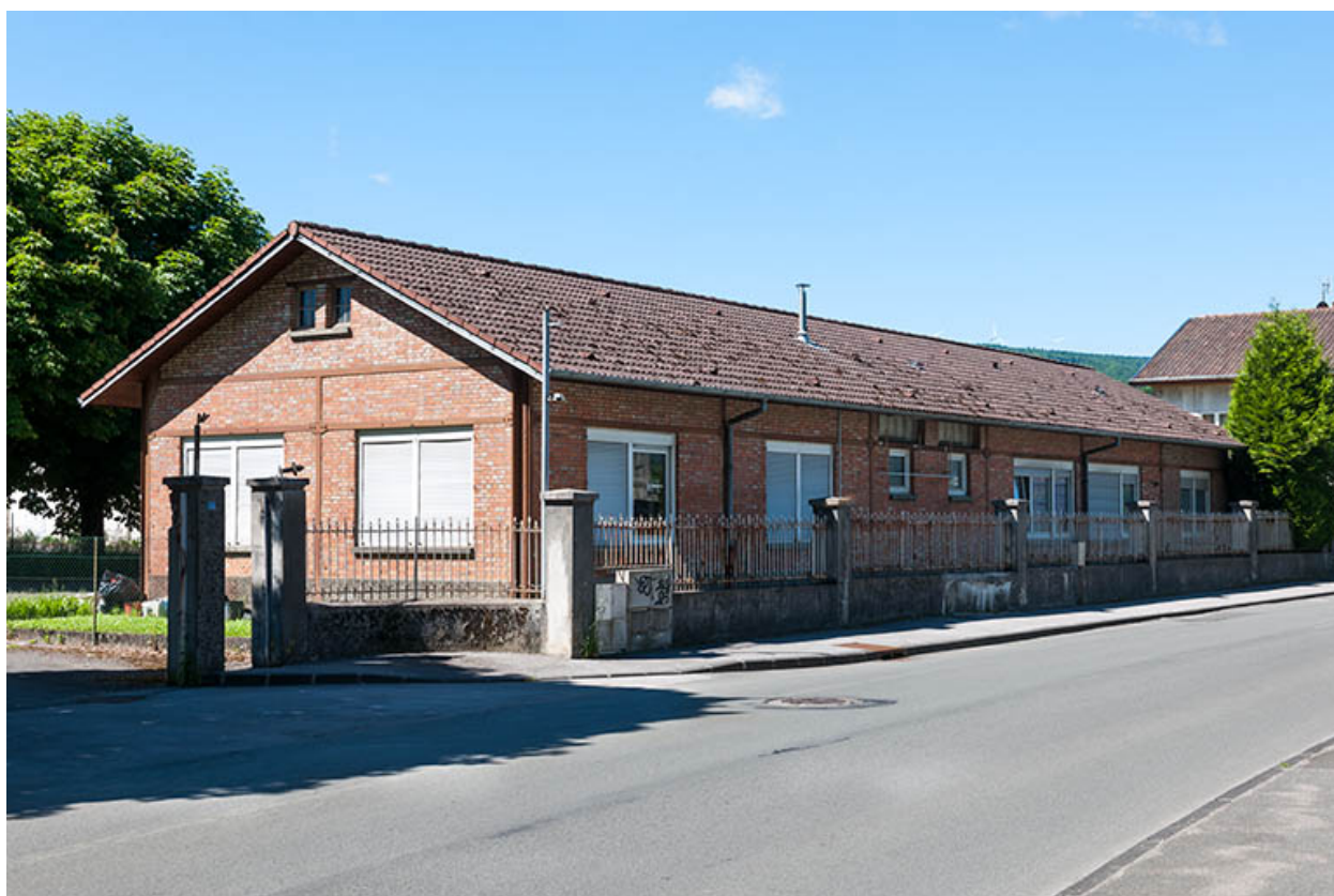
Bâtiment des logements et bureau.
