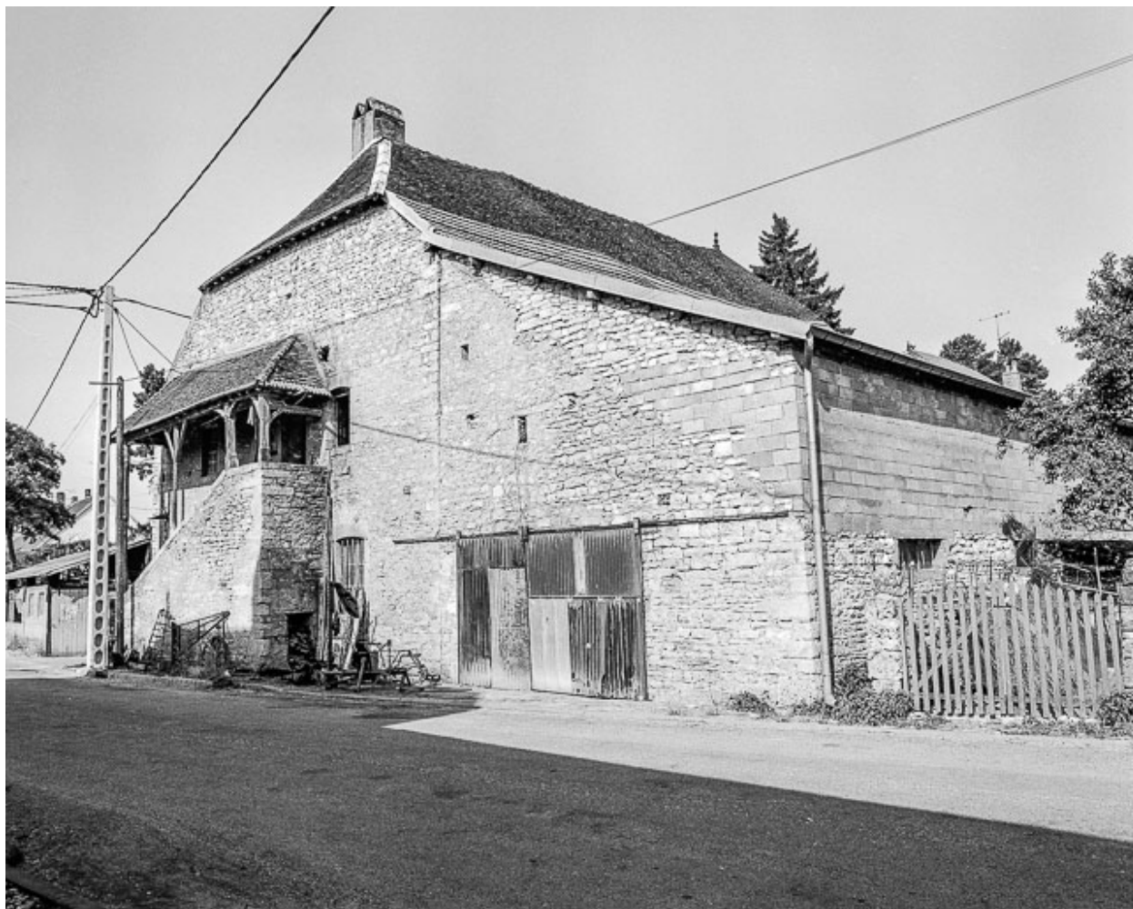
Façade avec escalier et dépendances.
