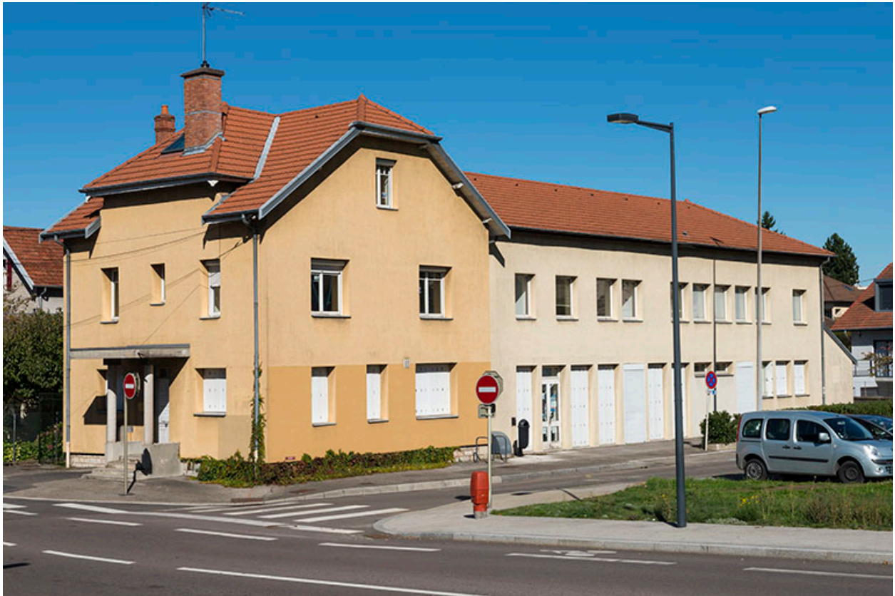
Vue de trois quarts, depuis le sud-ouest.
