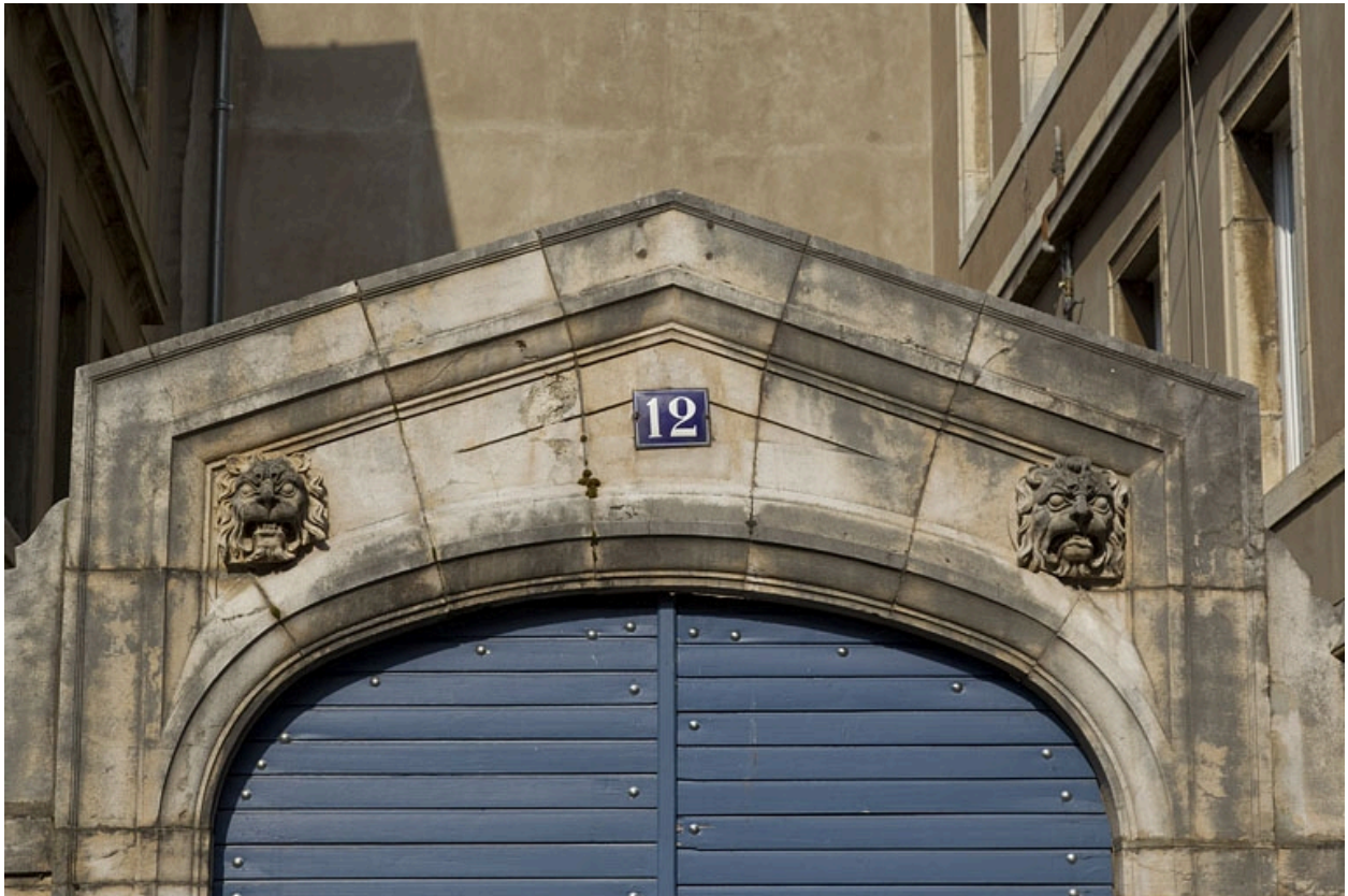
Portail d'entrée : détail de la partie supérieure.
