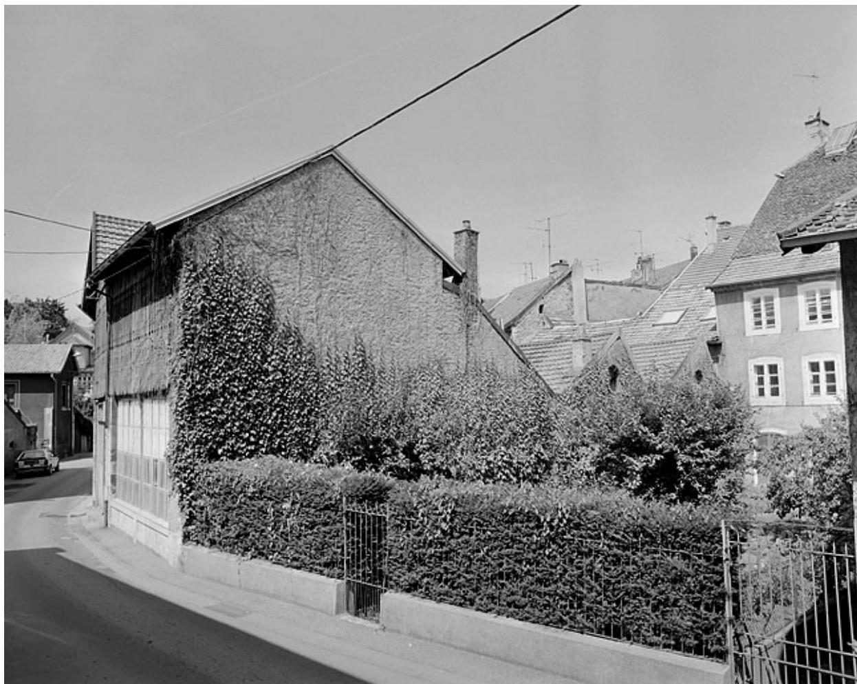
Façade latérale droite.
