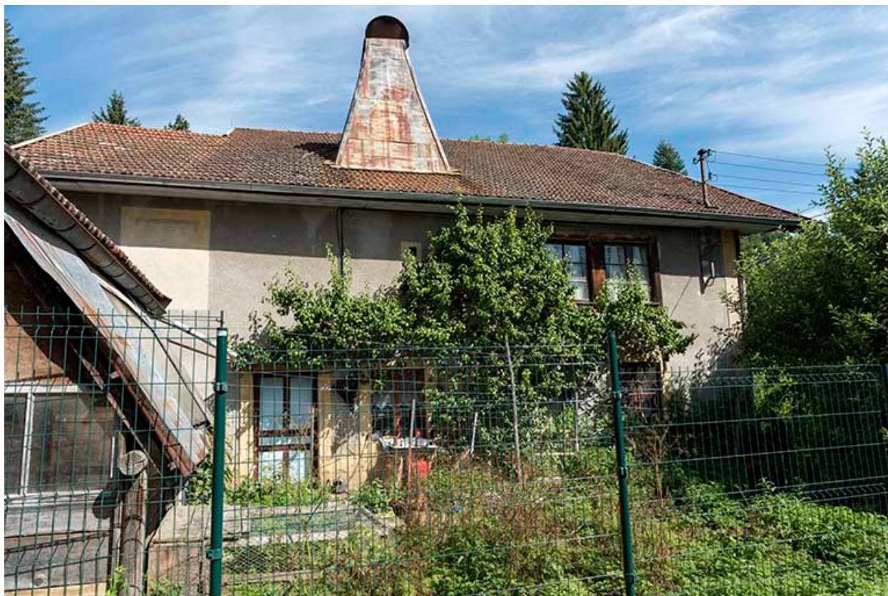
Façade latérale droite.
