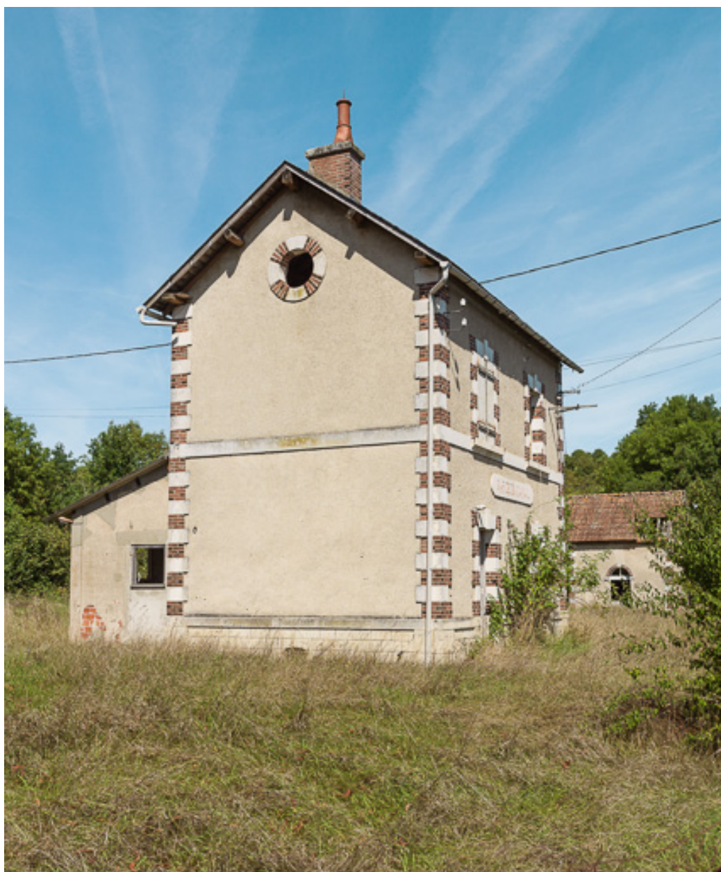
Vue d'une maison de barragiste.
