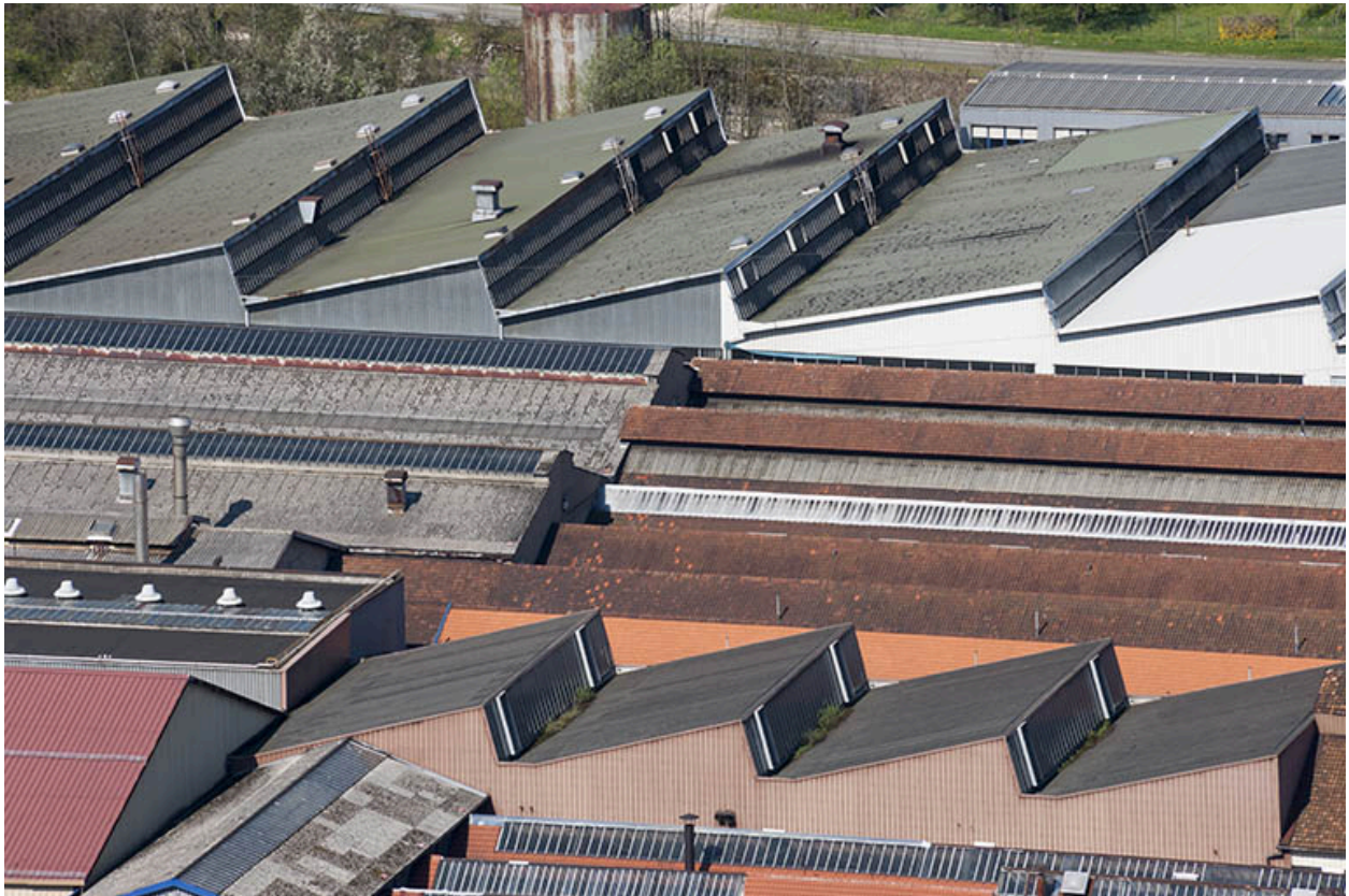
Détail de toitures des bâtiments industriels.
