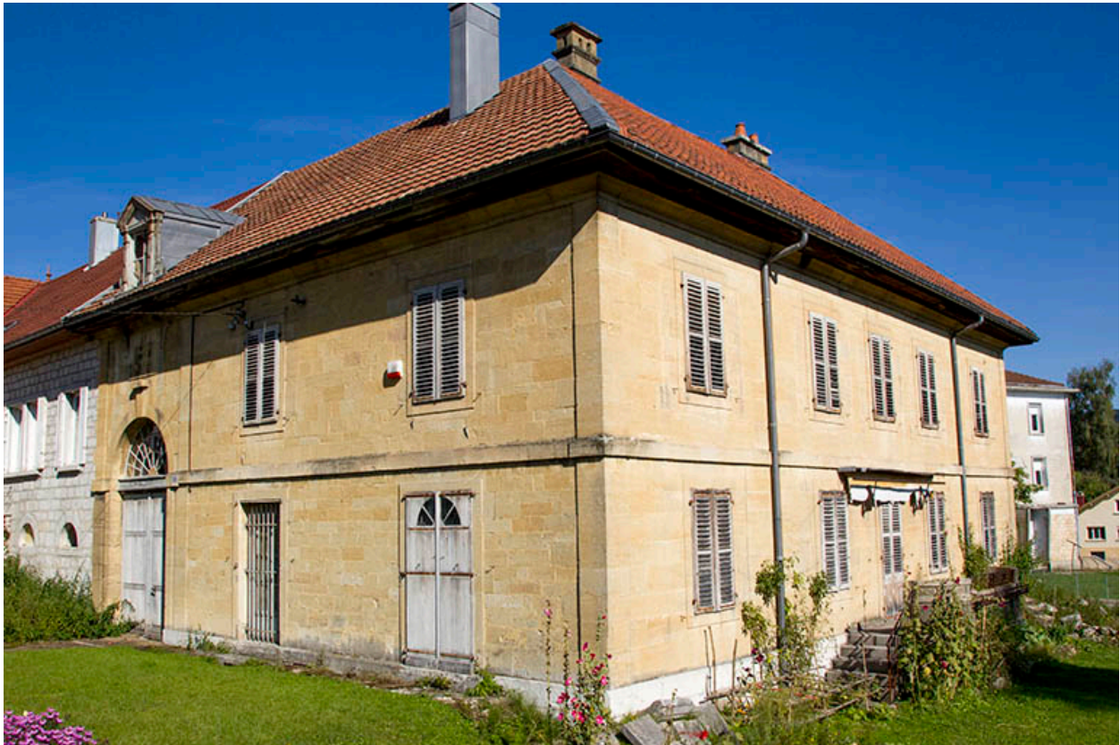
Corps sud : façades antérieure et latérale droite.
