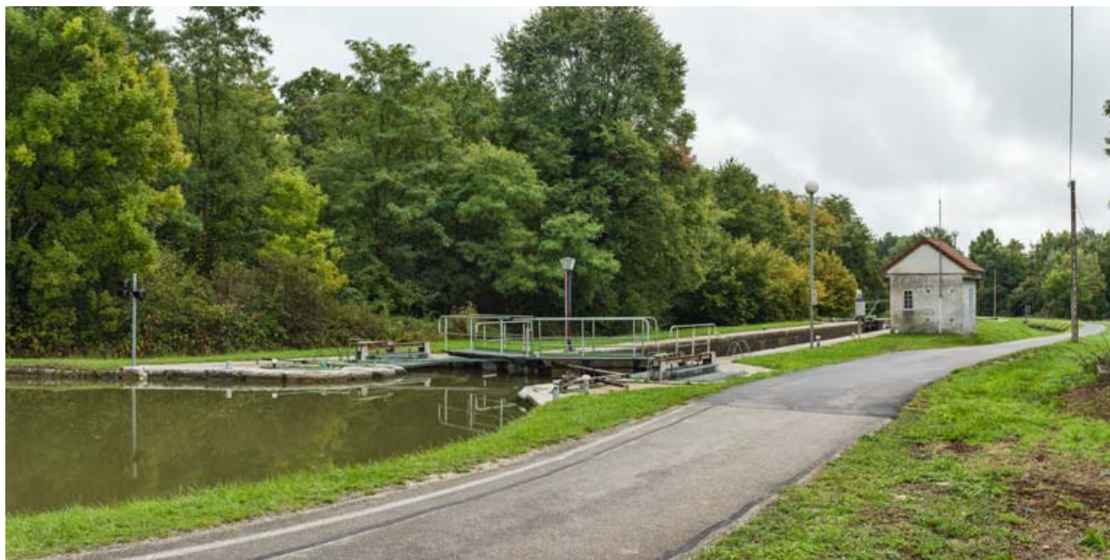
Vue d'ensemble du site d'écluse.
