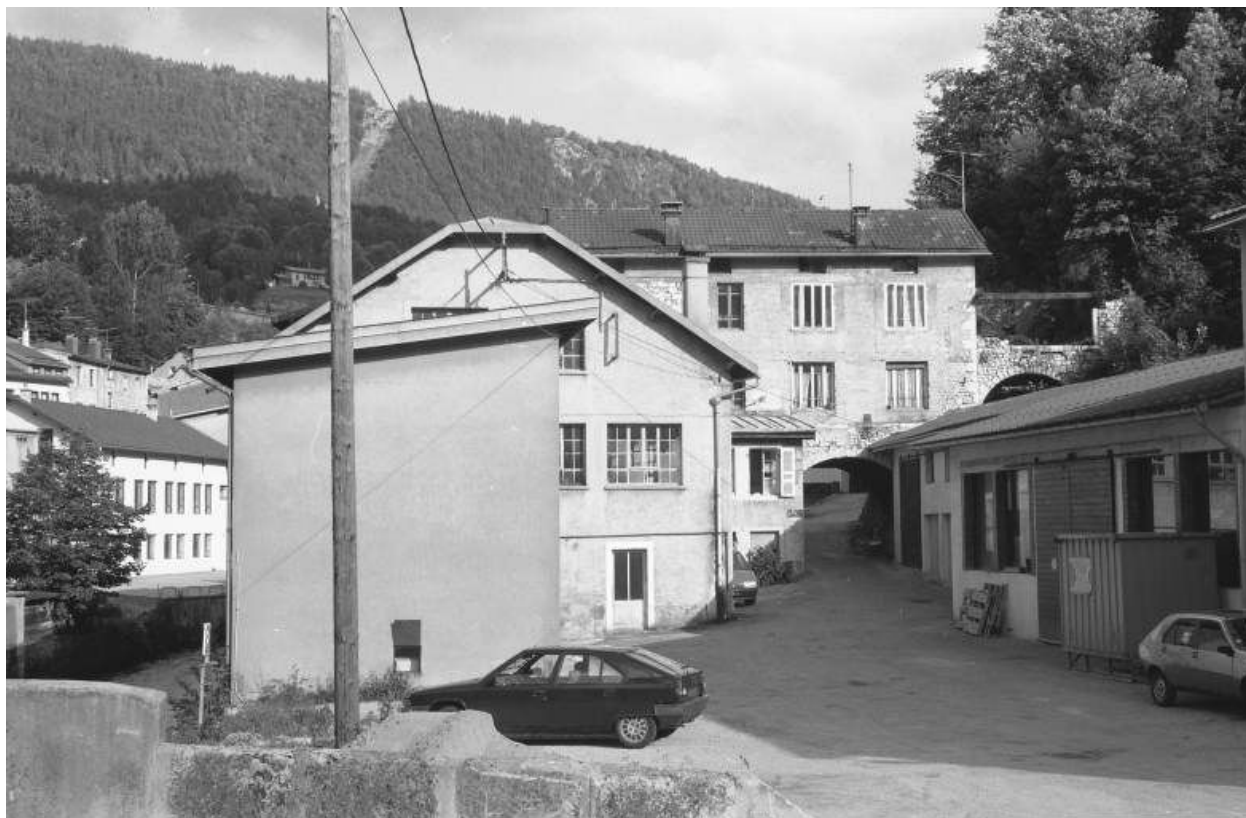
Vue d'ensemble depuis le nord-ouest (aval).
