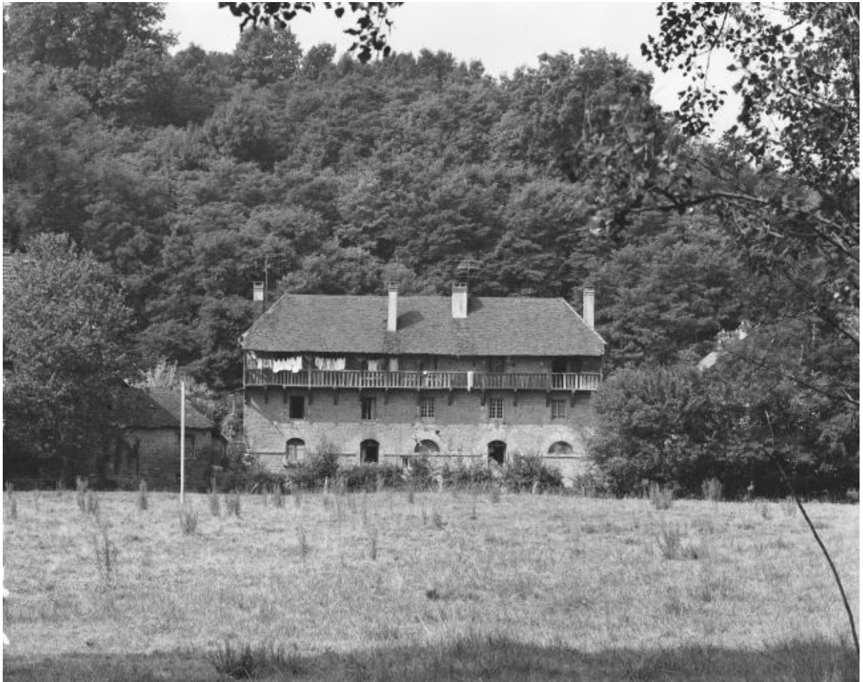
Façade postérieure d'un logement ouvrier.
