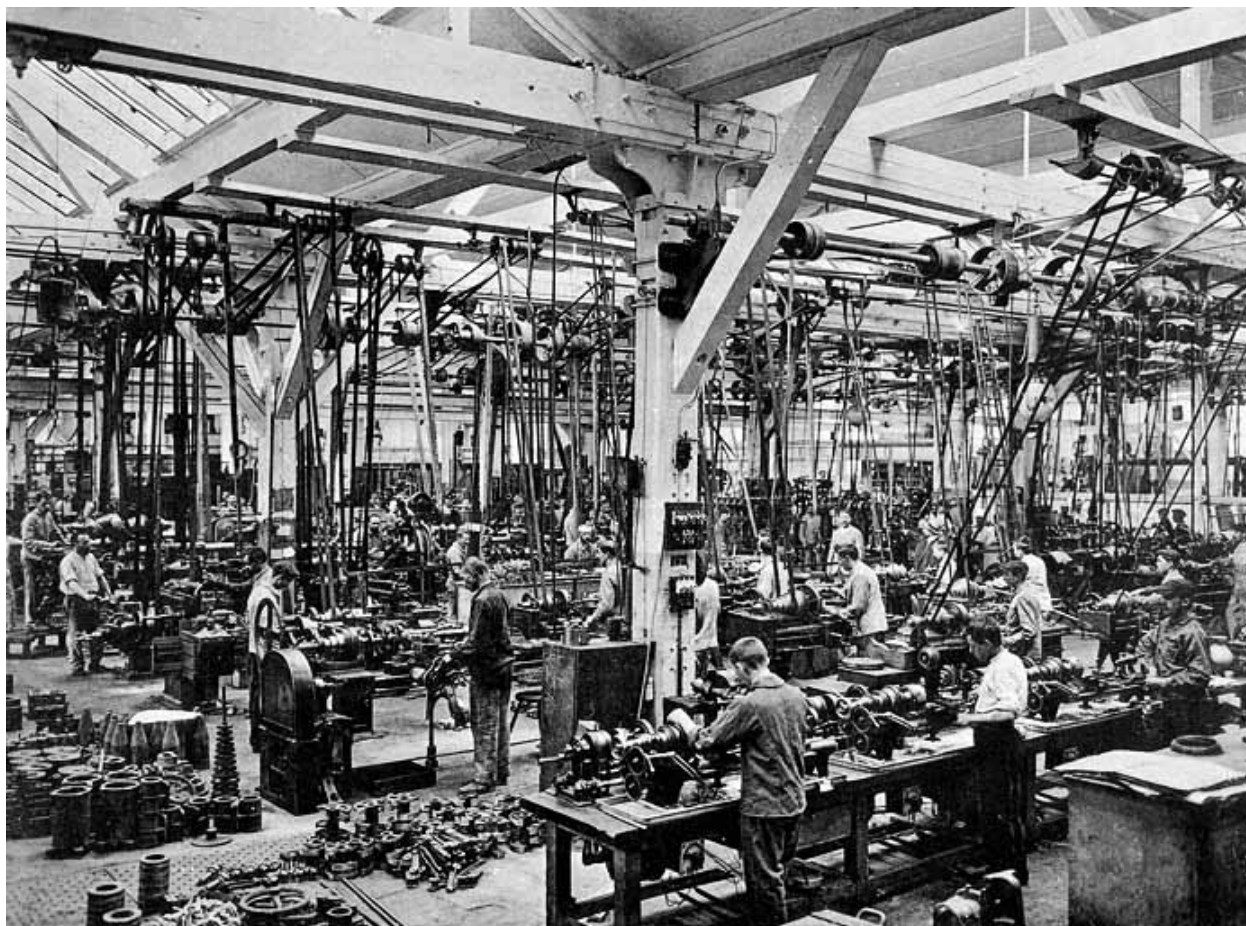
Atelier d'appareillage - Côté machines-outils.
