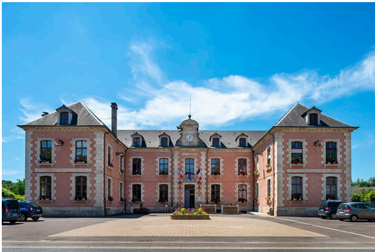
Façade nord-est, vue d'ensemble de face.
