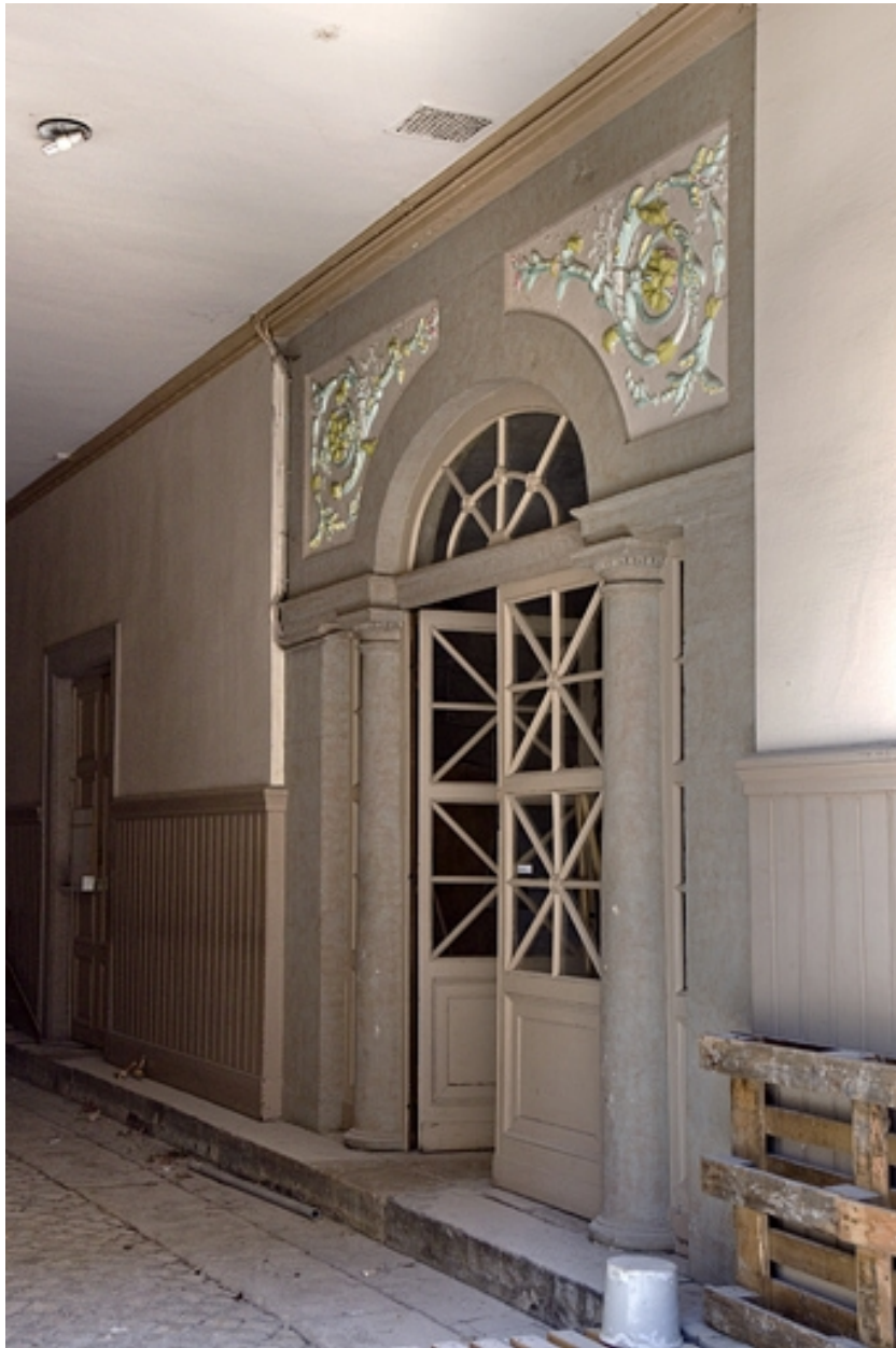
Passage cocher : détail de la porte d'entrée de l'escalier.
