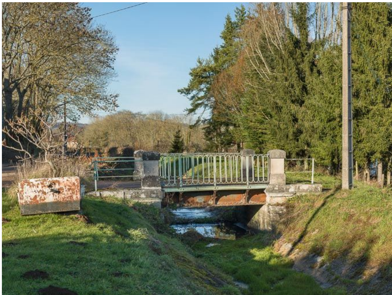
Vue d'ensemble du pont.
