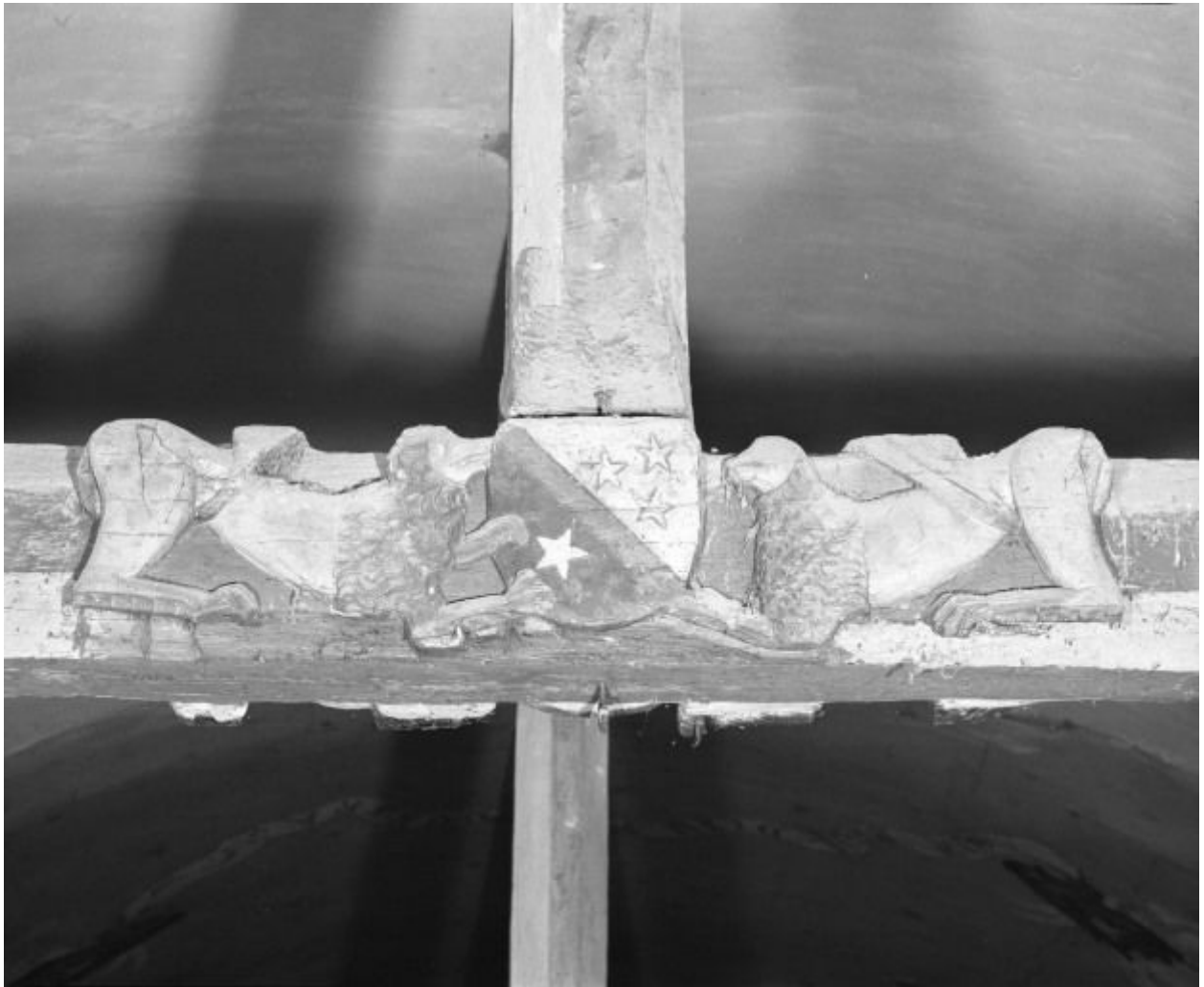
Charpente de la nef, décor du 4ème entrait
